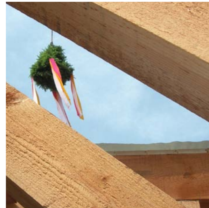
Wenn der Dachstuhl errichtet ist, wird das Richtfest gefeiert
