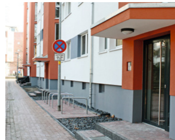
Gebäudeeingang: Ein neuer Anstrich verschönert die Außenfassade des Wohnhauses.
